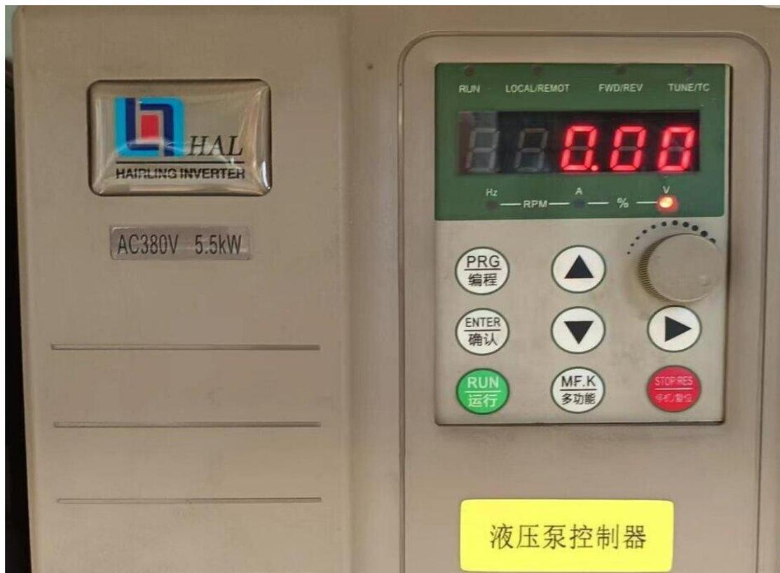
图 10. 电机电源切断显示
