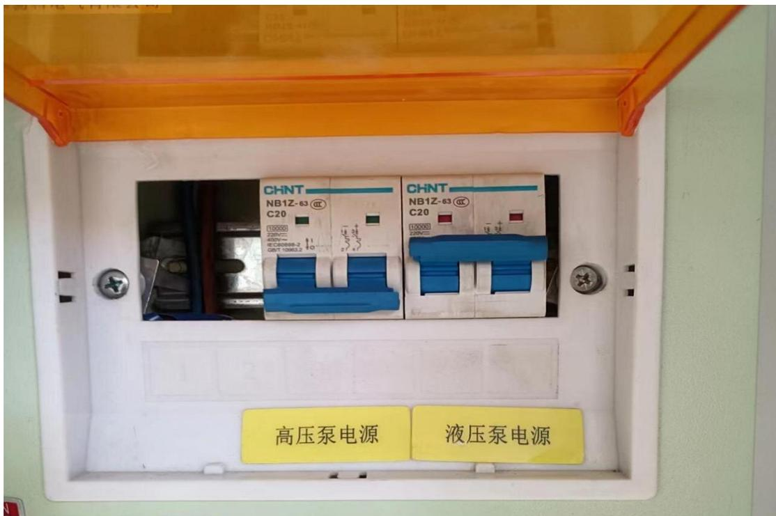
图 6 . 液压泵电源接通状态
